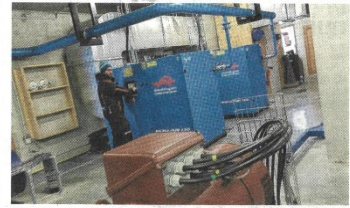
C'est dans la salle des machines, au pied du lac du Morond dans le Haut Doubs, que les compresseurs à air et à eau se mettent en activité pour fabriquer la neige de culture. Photo E. Joliot
